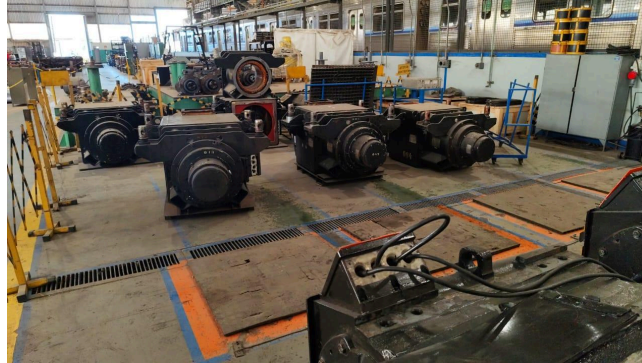
Figura 07: Moto conversores (MCVR) Metrô BH.
