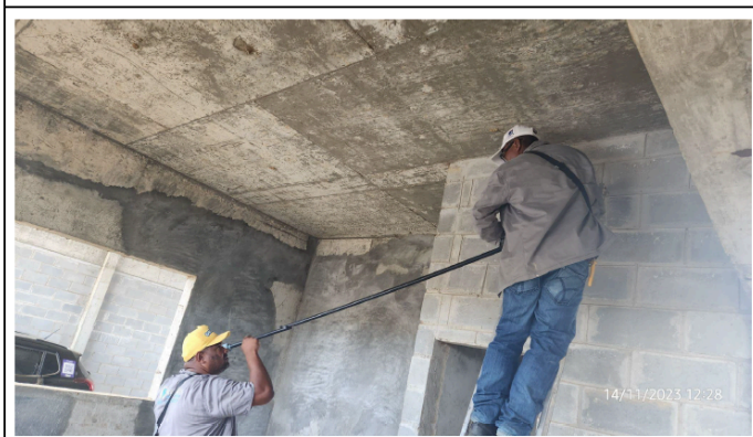
UPM-01 Lote II - Conclusão das instalações elétricas para a vigilância noturna
