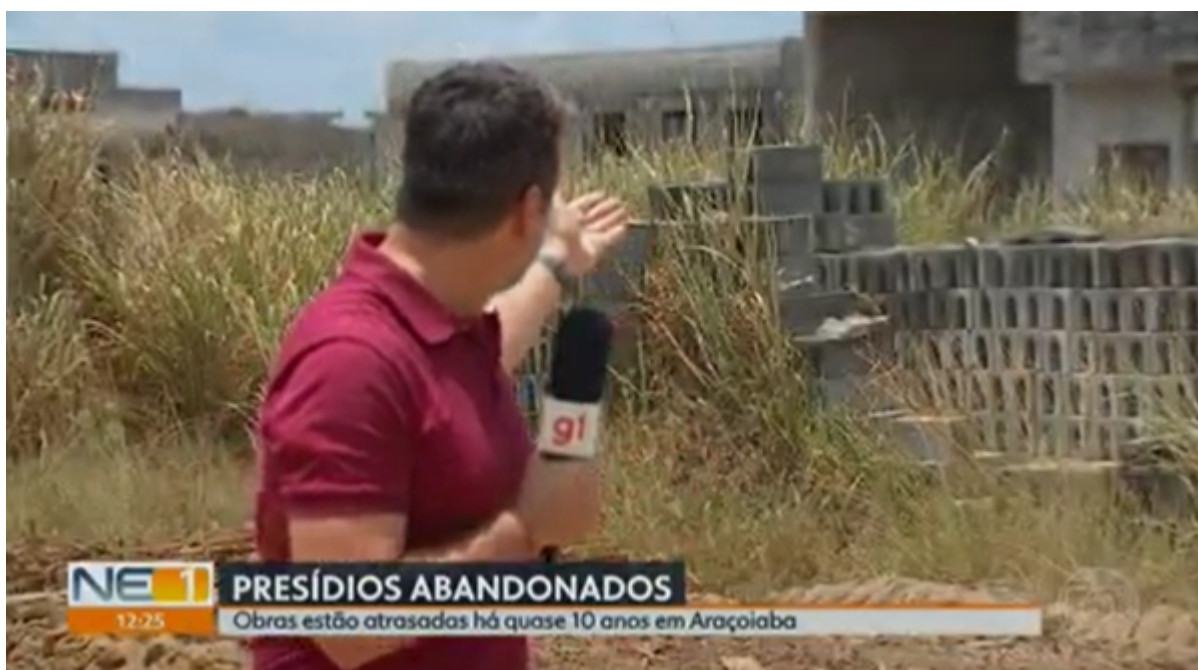
Figura 3 : excerto de reportagem sobre o abandono das obras de Construção das Cadeias Públicas no município de Araçoiaba/PE, em especial, no Lote nº 02
