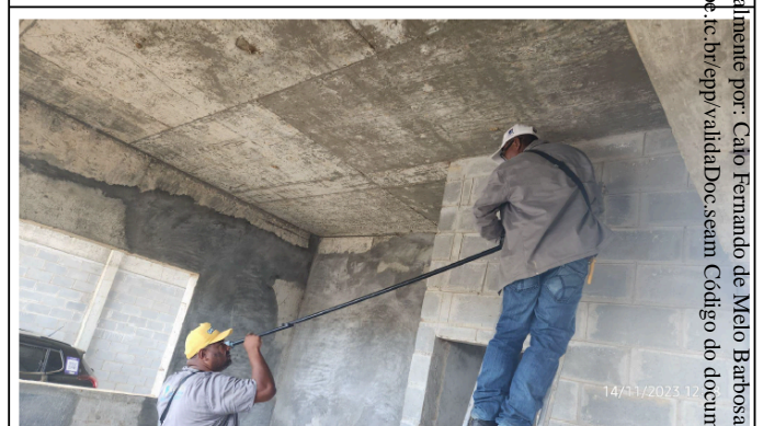
UPM-01 Lote II - Conclusão das instalações elétricas para a vigilância noturna
